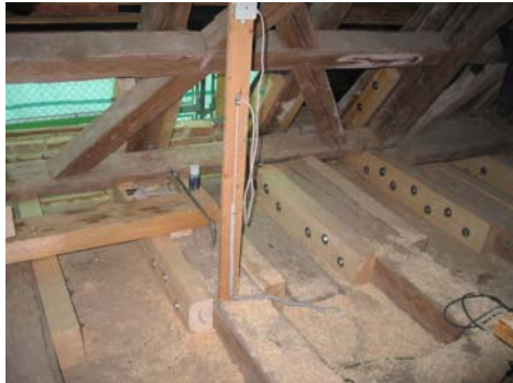
Instandsetzung Dachstuhl
