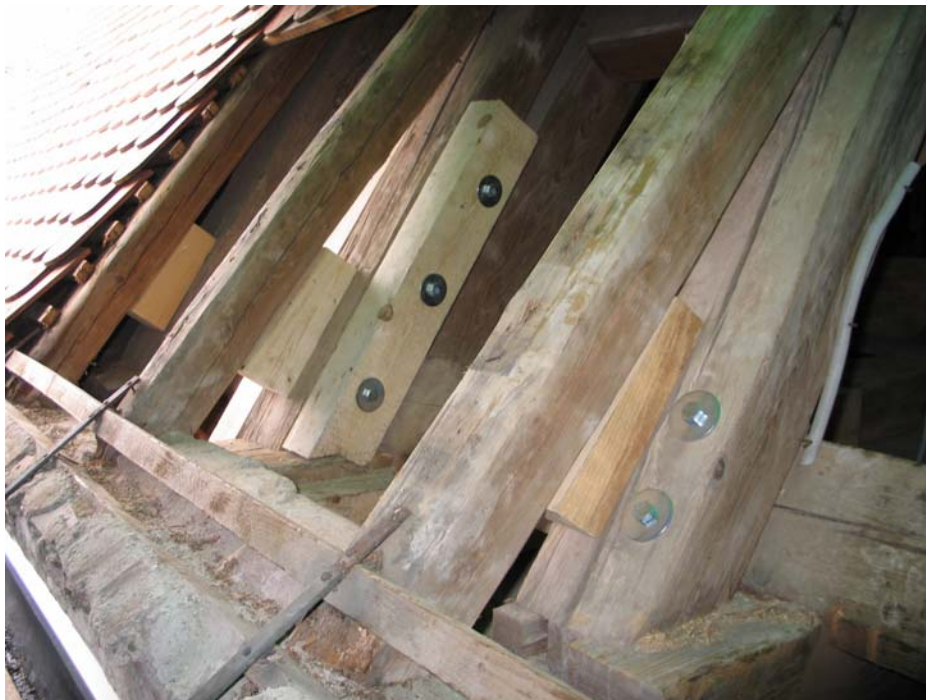
Instandsetzung Dachstuhl
