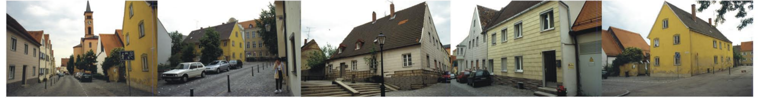
Vor dem Abbruch der ehemaligen Gebäude
